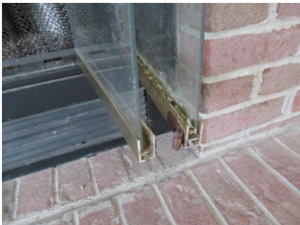
Broken hinge on fireplace door
